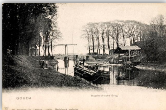
De situatie rond 1900. De brug lag toen plm. 80m ten westen van de huidige locatie.
